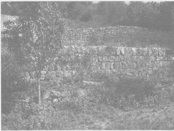
Vista de les terrasses.
