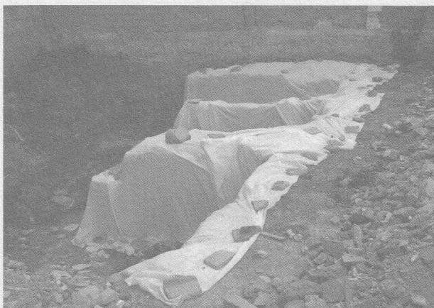
Treballs de protecció del baluard.
