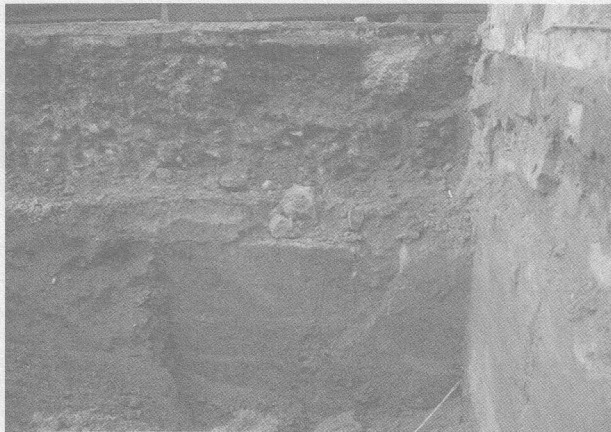
Murada, davall el parament de l'edificació existent.
