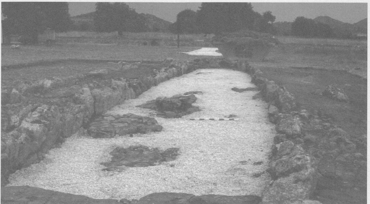
Estat del navetiforme I una vegada acabades les feines de consolidació i restauració. A l'interior es poden veure, per aquest ordre: una zona enllosada, una banqueta de pedra i la llar de foc.
