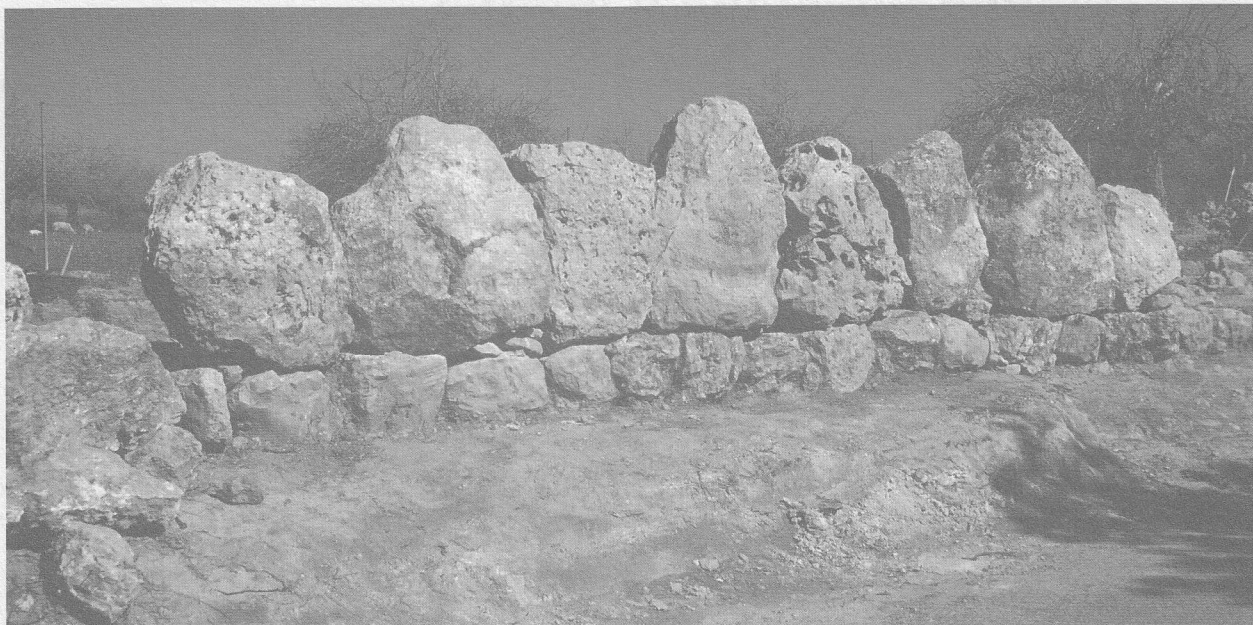
Sector nord de la murada, després de la restauració.
