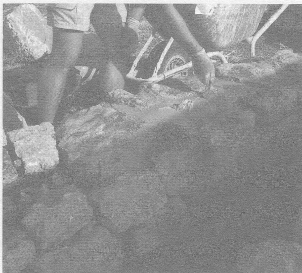
Figura 10. Procés de consolidació de les crestes dels murs mitjançant l'aplicació d'un morter de calç.
