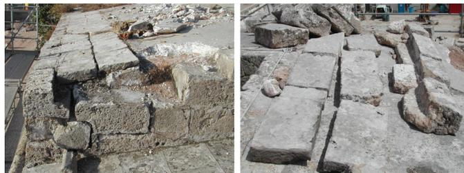
Figura 7. Sistema de trabado del coronamiento del Baluarte (Autor: Mateu Riera).
