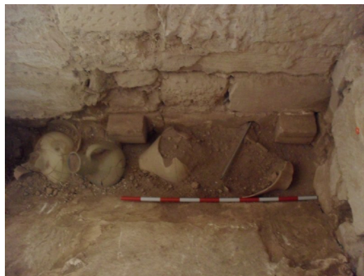
Fig. 6 Gerres i permòdols localitzats en el reblit de la volta de canó.
