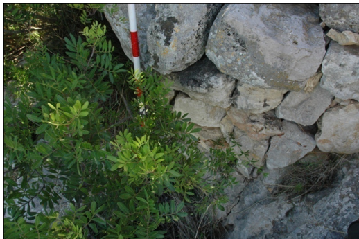
Figura 5: detalle nivelación exterior Torre I.
