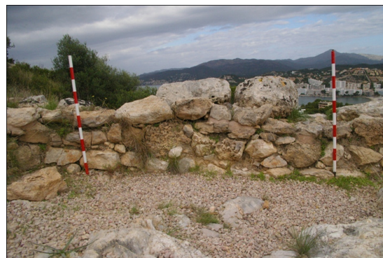
Figura 10: detalle paramento interior Torre I.
