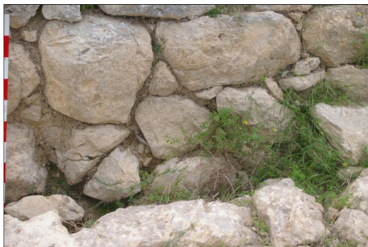
Figura 6: detalle nivelación exterior Torre I.
