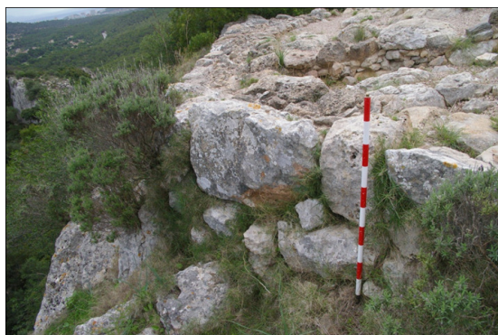
Figura 9: detalle Paramento exterior Torre I.
