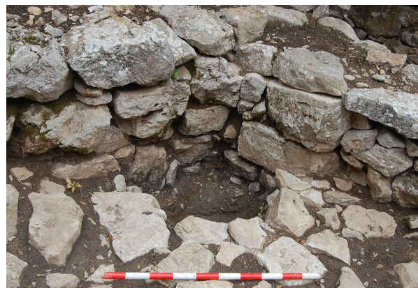
Fig. 10. Consolidació d'un petit dipòsit d'aigua a R11.
