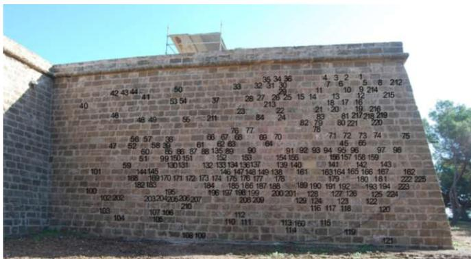
Figura 7. Imagen de uno de los lienzos del Baluarte del Príncipe con la señalización de las marcas localizadas (Autora: A. Martínez. Palma 2011).
