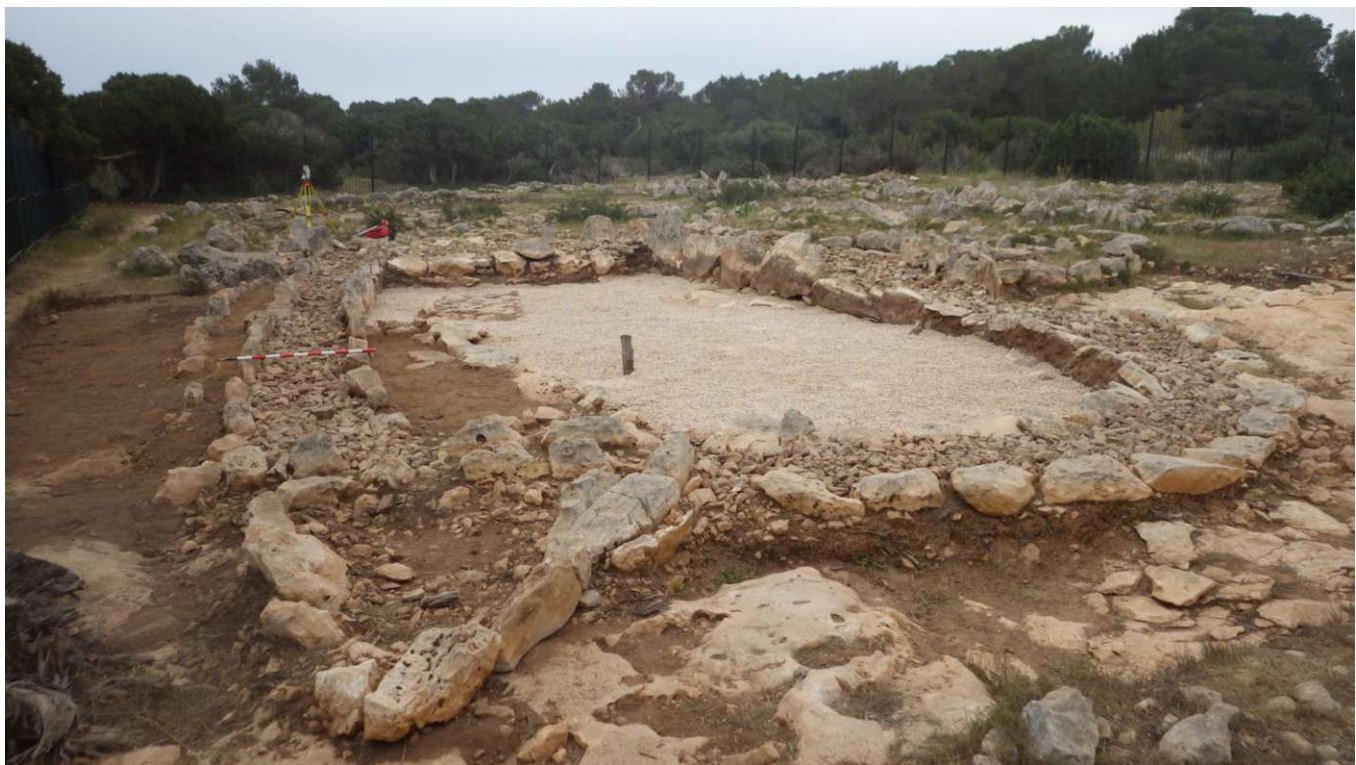
Figura 11: Vista general de l'estructura acabada la intervenció.
