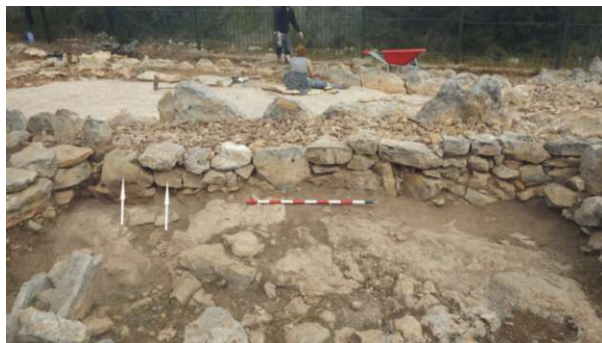
Fig. 6: Consolidació de la filada superior del mur. Totes les pedres són originals llevat de les dues marcades amb la fletxa, indispensables per a l'estabilitat estàtica del mur, assenyalades també a la Fig. 7
