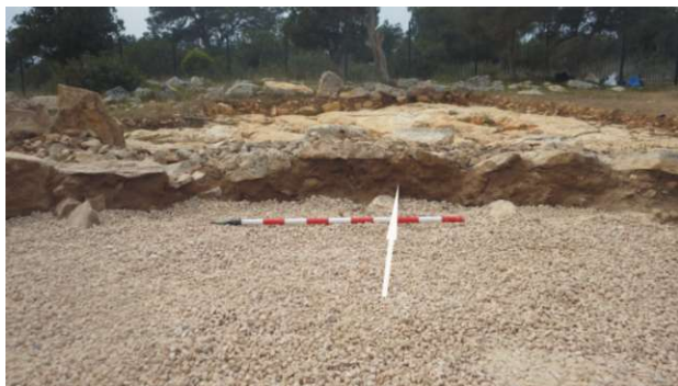
Fig. 5: Consolidació dels fonaments terrosos.
