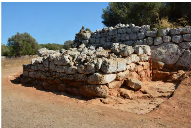
Figura 7. El bastión norte, levantado sobre la roca y adosado a la muralla talayótica, recreada con hiladas de sillares sobre los ortostatos ciclópeos (Fotografía: Modular 2016).
