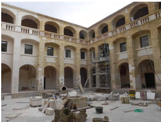
Figura 2. Vista de l'angle sud del pati del convent, en un moment avançat dels treballs de rehabilitació.
