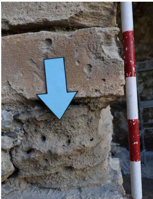
Figura 16. Detalle distintos sillares de marès empleado en la construcción.
