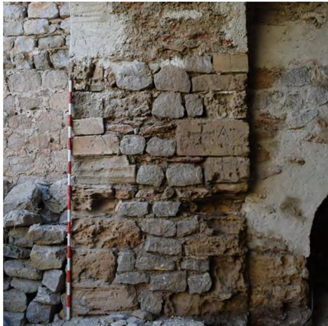
Figura 15. Detalle paramento de la casamata de blauarte Sant Jordi, en el que podemos observar distintos tipos de piedra marés, la reutilización de sillares (sillar con cruz heráldica) y presencia de marcas de canteria (sillar con posible cruz griega).
